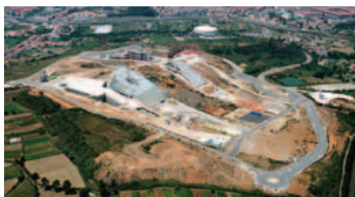
Visom geral das obras da Cidade da Cultura, no monte Gaiás
